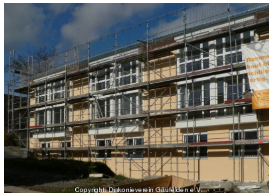
Copyright: Diakonieverein Gäufelden e.V. Baustelle am 15.11.2008
