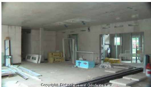
Copyright: Diakonieverein Gäufelden e.V. Baustelle am 15.8.2008
