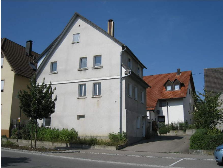
Ansichten der zwei alten Häuser vor dem Abbruch - von der Sindlinger Straße aus gesehen
